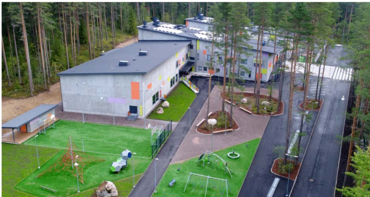
Kuva 30. Pontuksen päiväkotikoulu © Lappeenrannan kaupunki.
