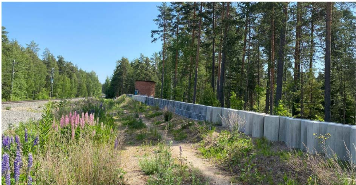
Kuva 4. Kokeellinen meluaita Pontuksen koulun kohdalla, radan varressa.
