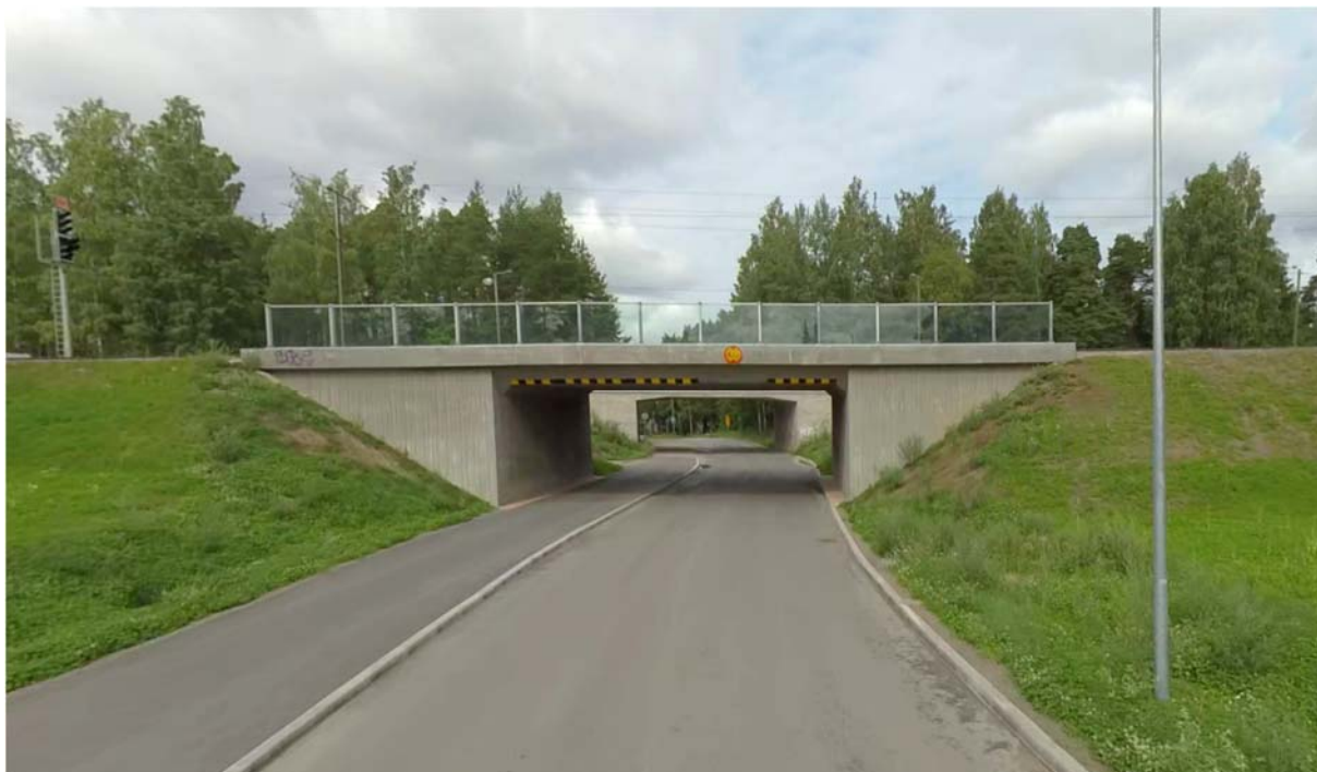
Kuva 17. Uusittu Hakalintien alikulkusilta. (Lappeenrannan kaupunki 2022)
