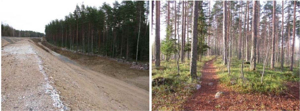
Kuva 26. Vasemmalla levennetty ratapenger Muukontien alikulun itäpuolella. Oikealla radan eteläpuolisen selänteen iäkästä mäntymetsää. (Afry, 2023d)
