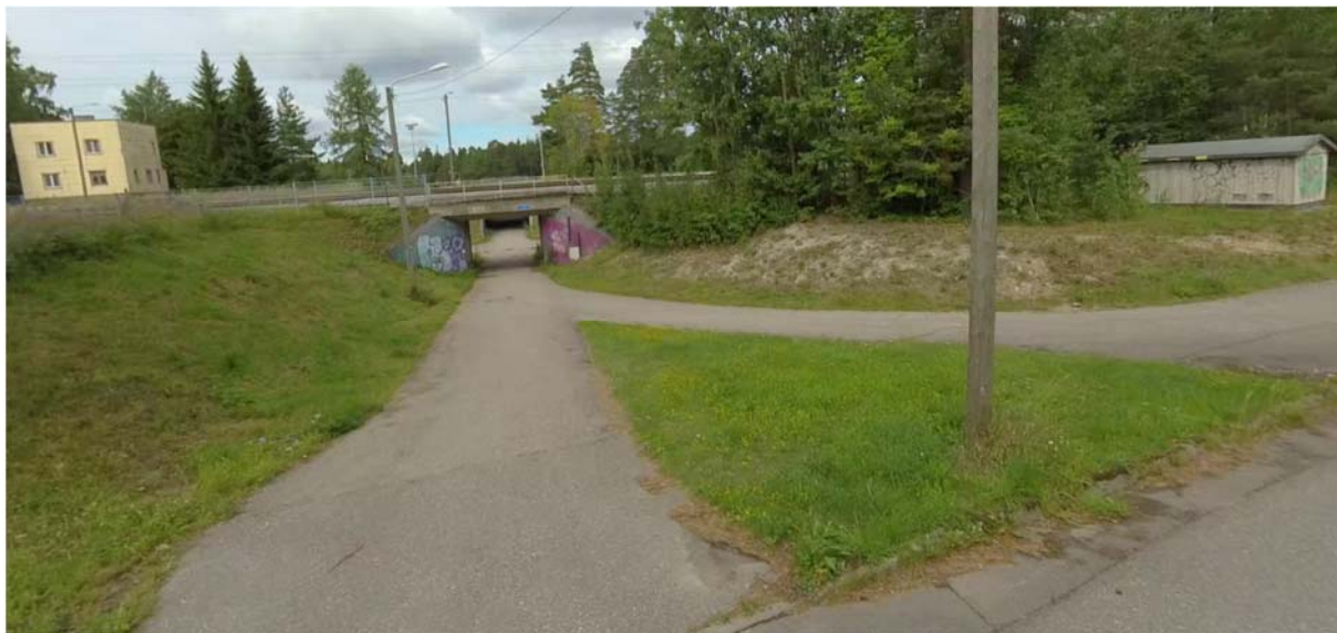
Kuva 16. Kevyen liikenteen alikulkusilta. Sillan oikealla puolella on puistomuuntamo. (Lappeenrannan kaupunki 2022)
